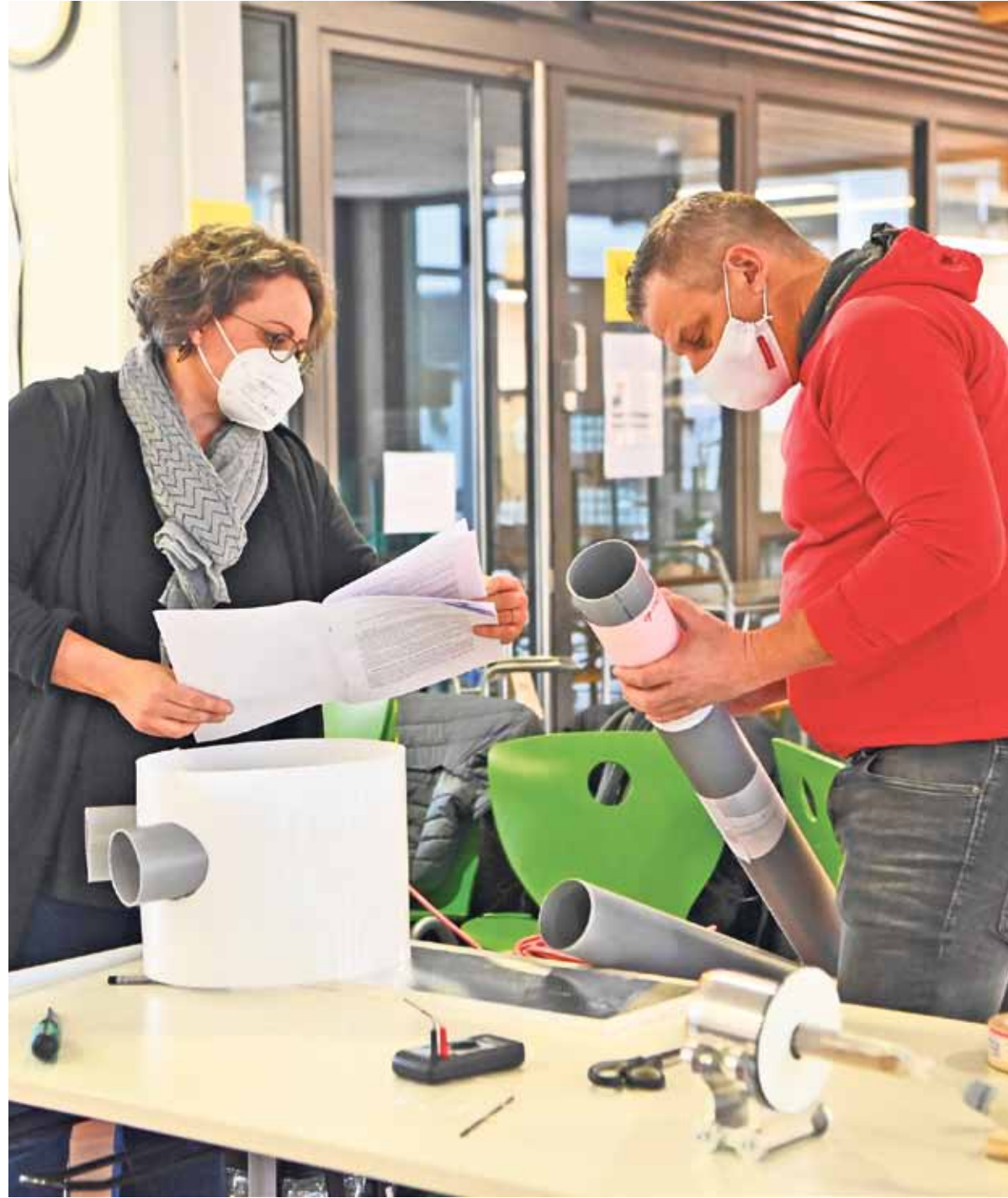
Eltern basteln in der Mensa des Ludwig-Uhland-Gymnasiums: Es geht nicht um eine schöne Dekoration, sondern um eine Anlage, die verbrauchte Luft aus Klassenzimmern absaugt. Foto: Markus Brändli
